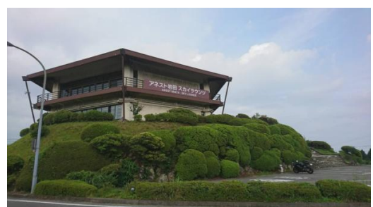
アネスト岩田 スカイラウンジ
